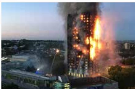
Häusern der SWG nicht zum Einsatz. Das 24-stöckige Hochhaus in London war mit einem Aluminiumverbundstoff gedämmt. Diese Art von Fassadenverkleidung ist in einigen Fällen leicht entzündbar und wirkte im Londoner Fall wie ein Brandbeschleuniger. Diese Dämmstoffe sind an unseren Häusern nicht verbaut.
